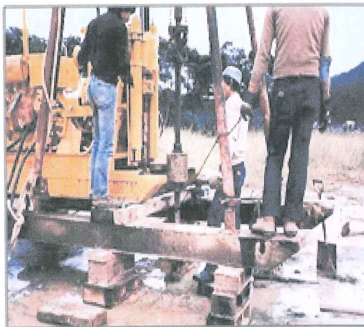
CẮT CẢNH HIỆN TRƯỜNG, THÍ NGHIỆM SPT
