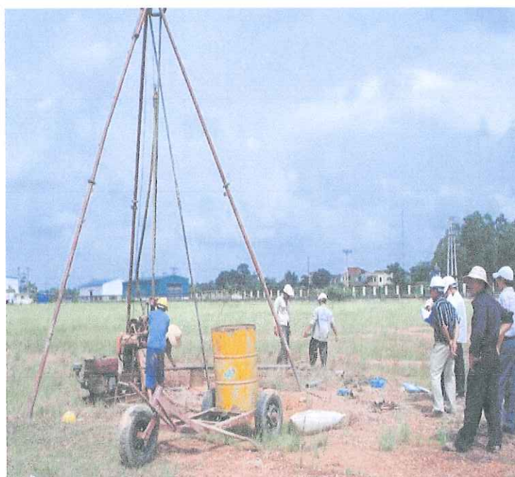
KHOAN KHẢO SÁT ĐỊA CHẤT CÔNG TRÌNH
